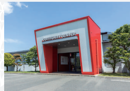
エントランスゲート
